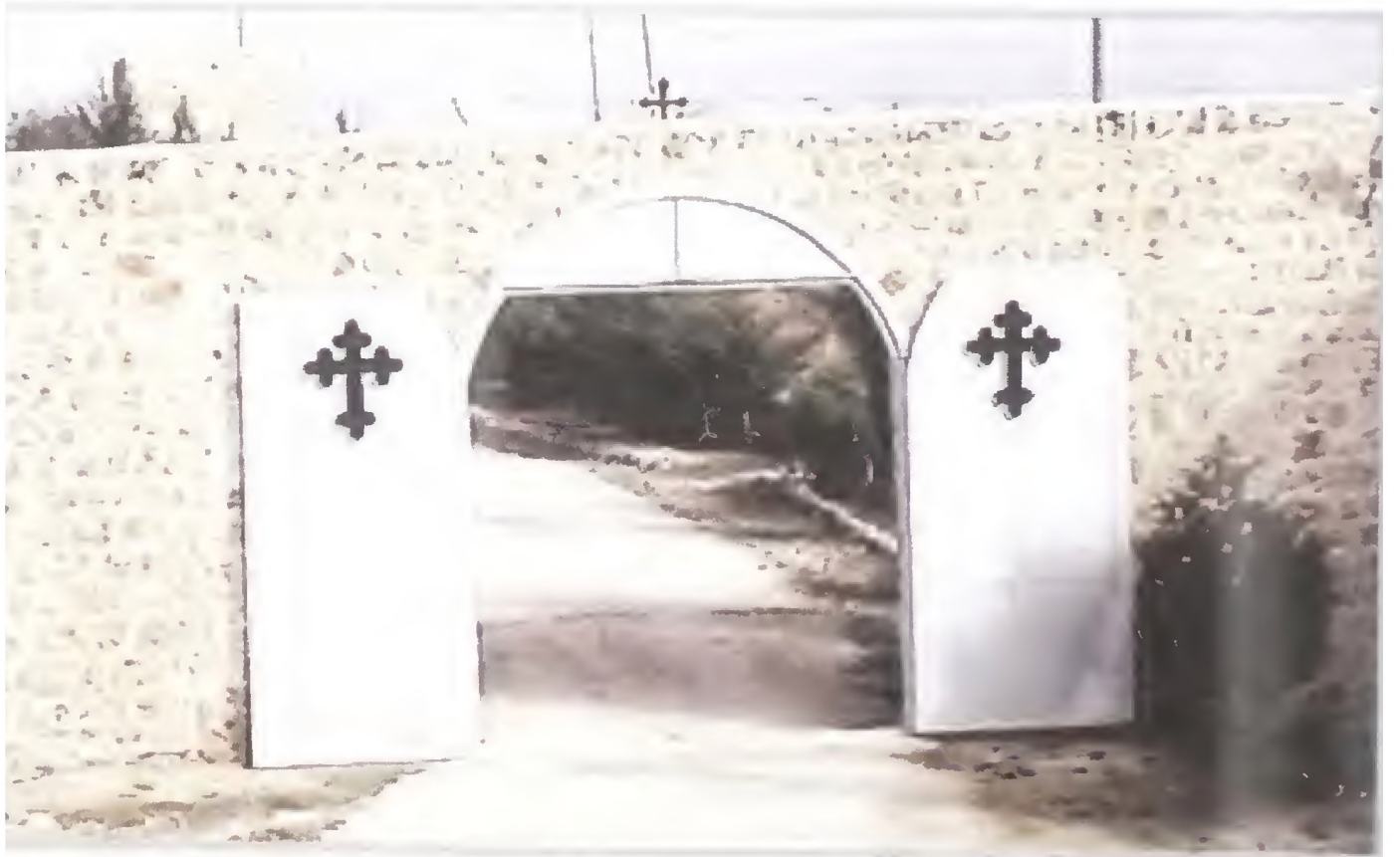
• Rahip İšo ATAŞ'ın inşa ettiği duvarların görüntüsü
